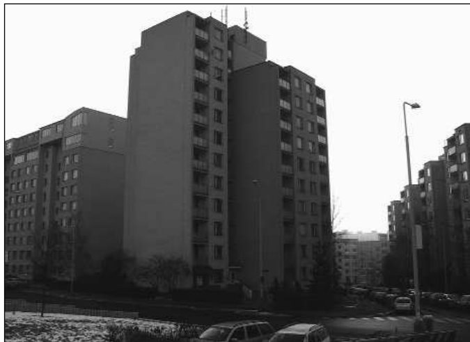
Pohled na dům, kde jsou byty, od stanice metra
